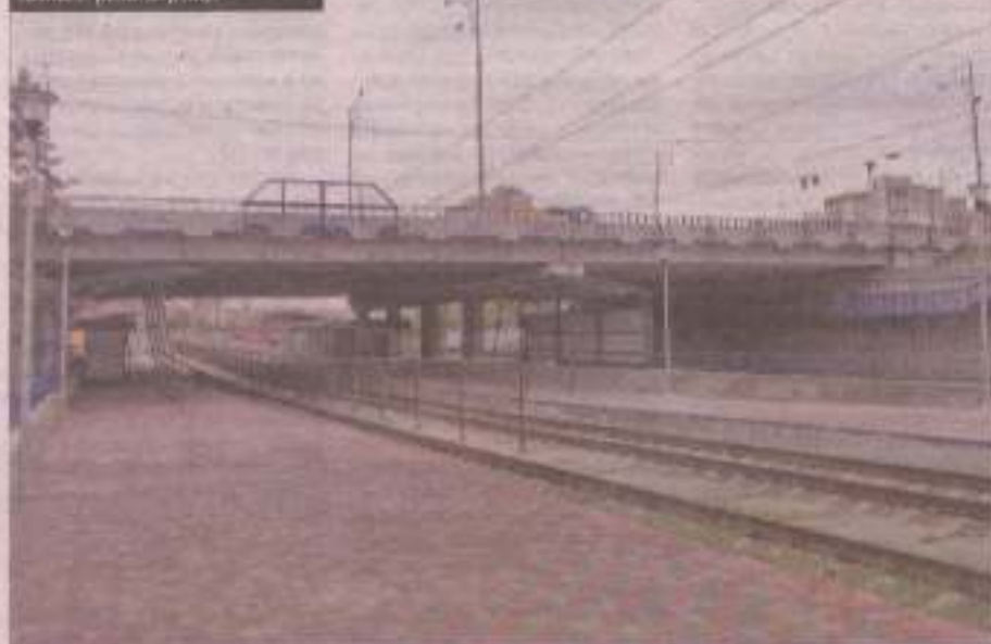
Станція на швидкохідній лінії реконструйована
