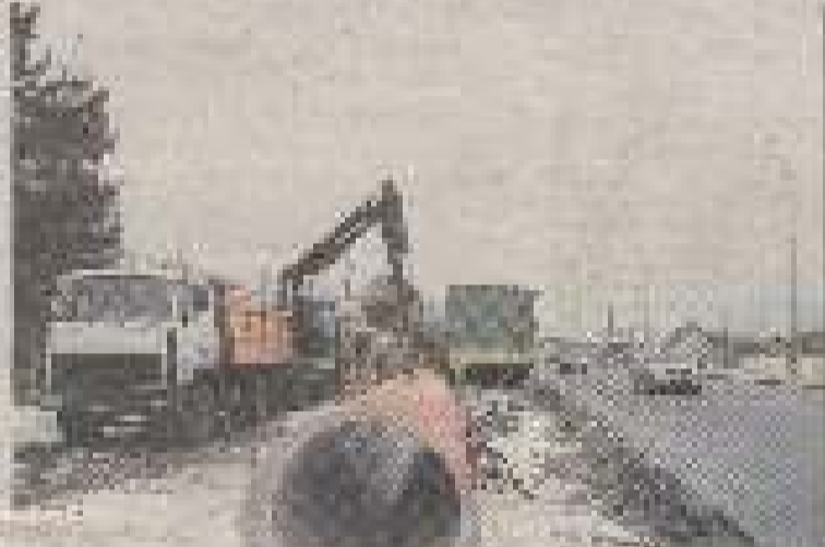
Будівництво каналізаційної мережі в місті.
